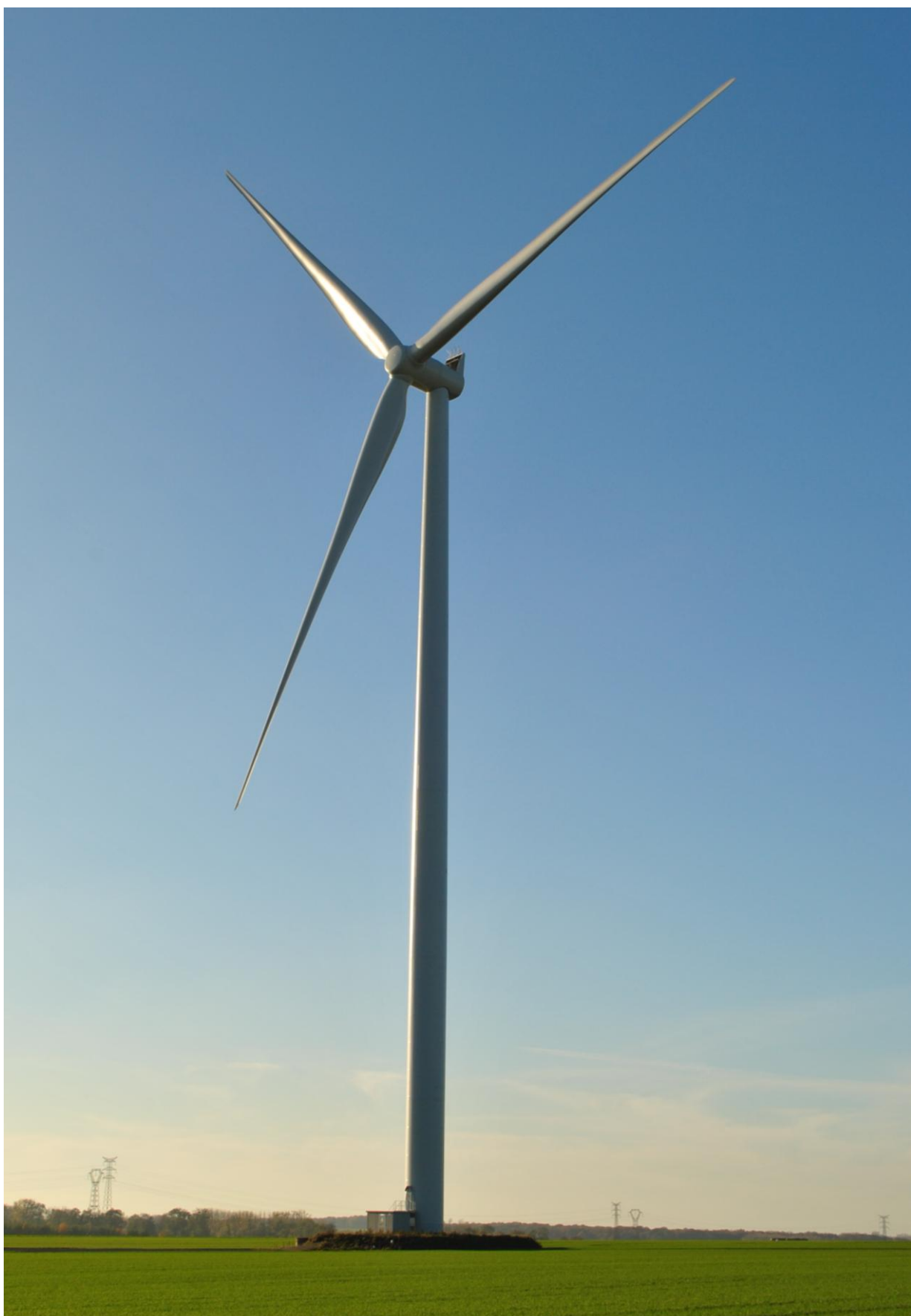
Figure 11 : La SWT3-113 du parc éolien de Buire-le-Sec
