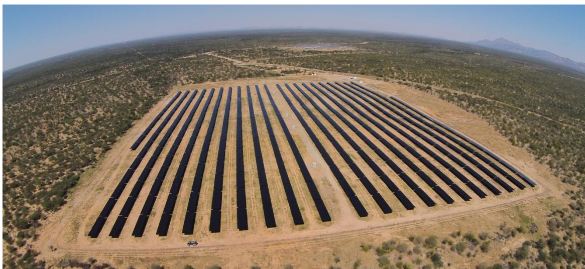
Figure 8 : Parc photovoltaïque d'Omburu (5 MW), Namibie, 2015. Développé par InnoSun, filiale d'InnoVent.
