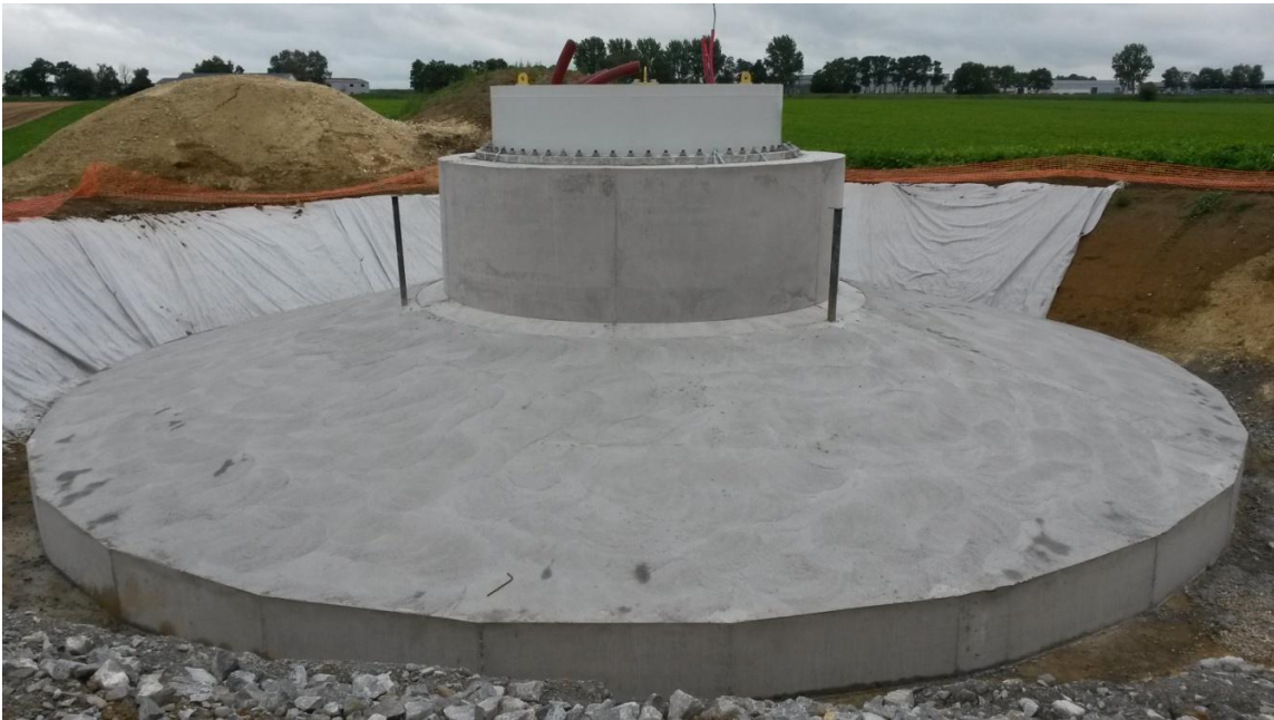
Figure 12 : fondation d'une éolienne, parc éolien de l'ouest royen (80)
