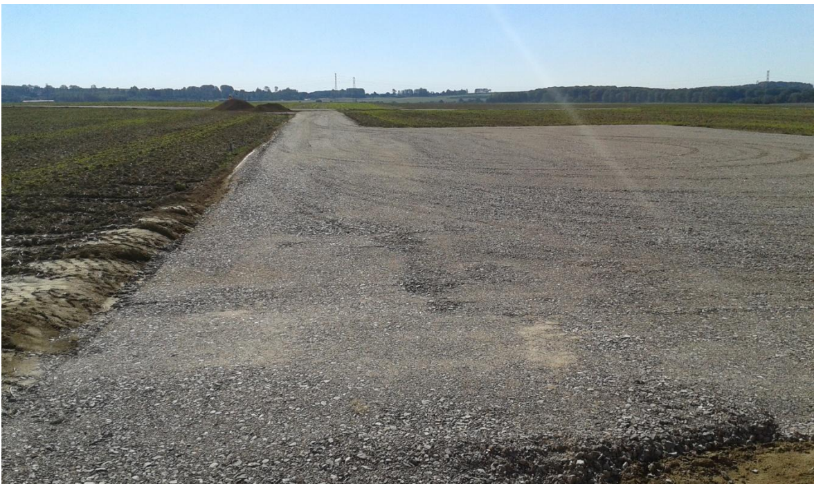
Figure 13 : Plateforme d'éolienne et voie d'accès, état final (parc de Buire-le-Sec)
